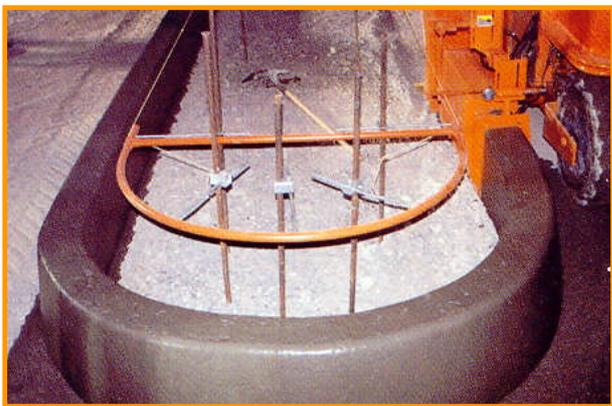
La machine à coffrage glissant **MBW** est idéale pour réaliser des rayons très serrés sur bordures ou bordures caniveaux, en conservant une qualité de finition impeccable.
